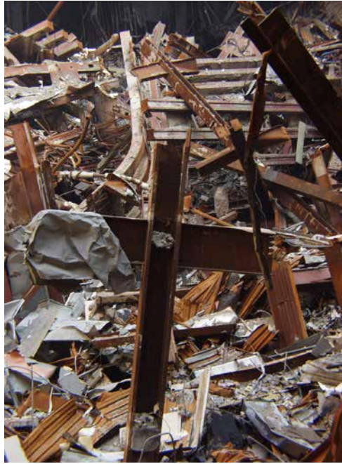
Michael Rieger: Ground Zero (6 World Trade Center): Kreuzform in den Trümmern , 2001, Fotografie FEMA News Photo (Federal Emergency Management Agency), New York, 26. September 2001 (Digitalisat: Wikimedia Commons) Public Domain (Werk eines FEMA-Mitarbeiters im Dienst; U.S. federal government work)
